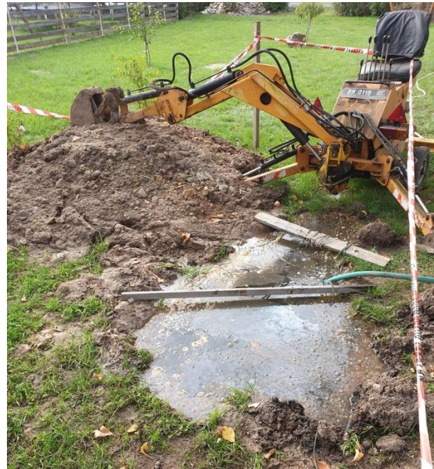
Obr. 14: Přelivový vrt zemního výměníku.
