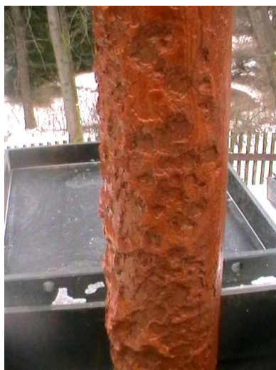
Obr. 4: Elektrochemicky vysrážené oxo-hydroxidy železa na antikoro výstroji.
